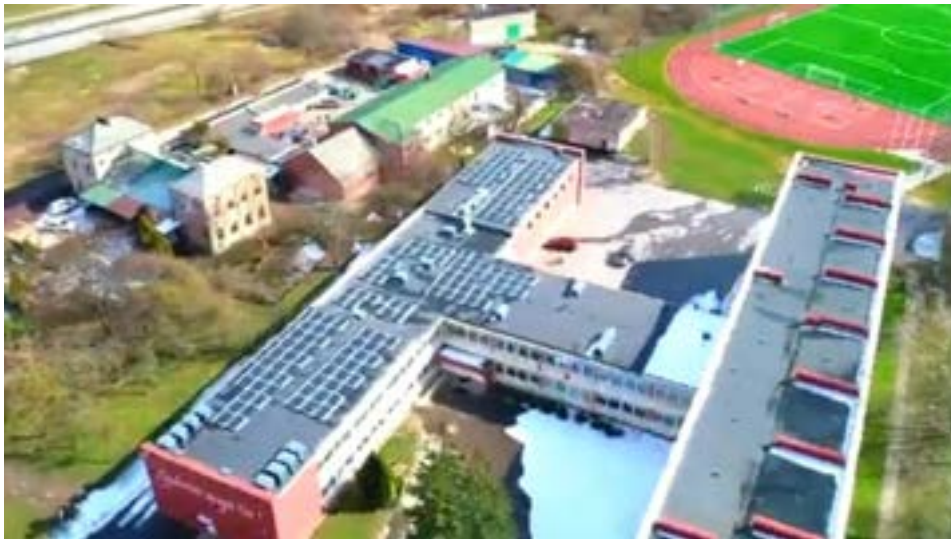
Klaipėdos Verdenės pradinė mokykla, 50 kW saulės elektrinė
